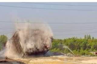
Die Sprengung – monatlang wurde sie vorbereitet.
