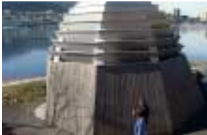
Bei Regen soll das Wasser in einer Spirale durch das Dach und die ganze Hütte strömen
