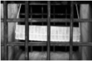
Im Windkanal testeten die Gebrüder Wright Flügelformen und Anstellwinkel
