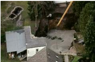
Das „Bochumer Loch“ musste mit ca. 50.000 Kubikmetern Beton aufgefüllt werden
