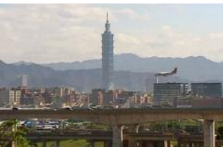
Der Taipei Tower 101: Ein 660 Tonnen schweres Pendel hält ihn im Lot
