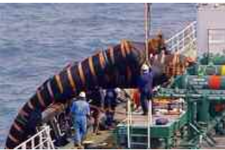
Schwimmende Pipelines: In diesen Leitungen wird das Öl an Bord gepumpt
