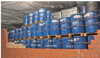
Die Deponiekammern werden zugemauert © dpa
