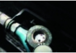
An der Wasseruhr enden die Kontrollen der Wasserversorger
