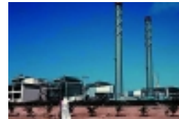
Eine Meerwasserentsalzungsanlage in der Hafenstadt Dschidda in Saudi-Arabien
